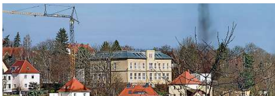
Der Bau der Questenbergschule geht weiter voran.
